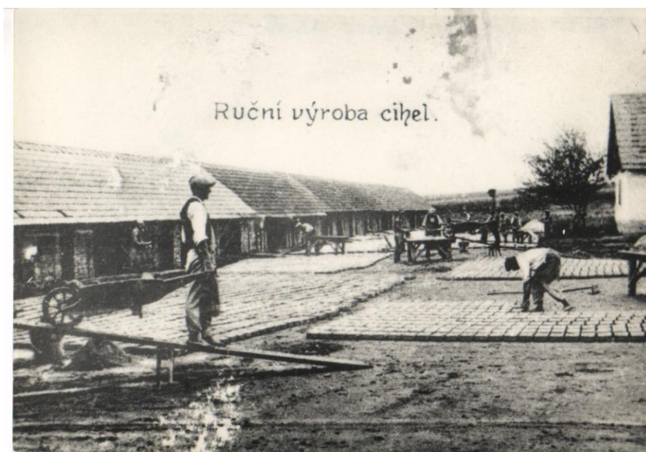
Jediná mechanizace dřevěná „kolečka“.
