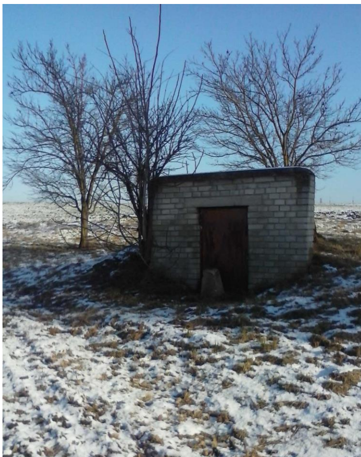
Studýnka na Spodním díle nově vyzděná dnes
