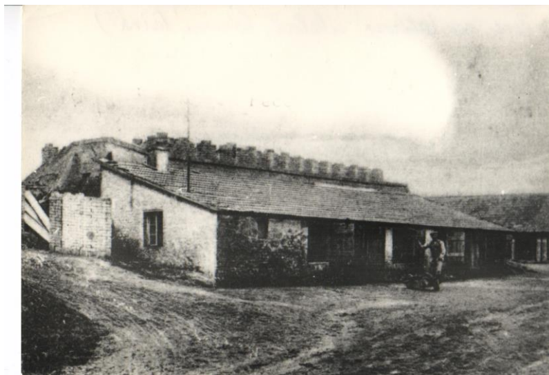
Dvě pece s řadami „výdechů“, které vyčnívají za přístřeškem na ukládání cihel.
