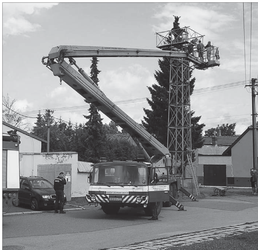
Blažovičtí hasiči spolu s HZS JMK, stanice Pozoříce, při údržbě stožáru.
