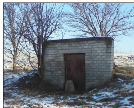
Studýnka na Spodním díle nově vyzděná dnes
