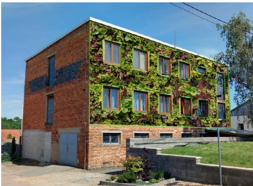
Obr. 2.16 Navržené řešení zelené fasády na západní straně
