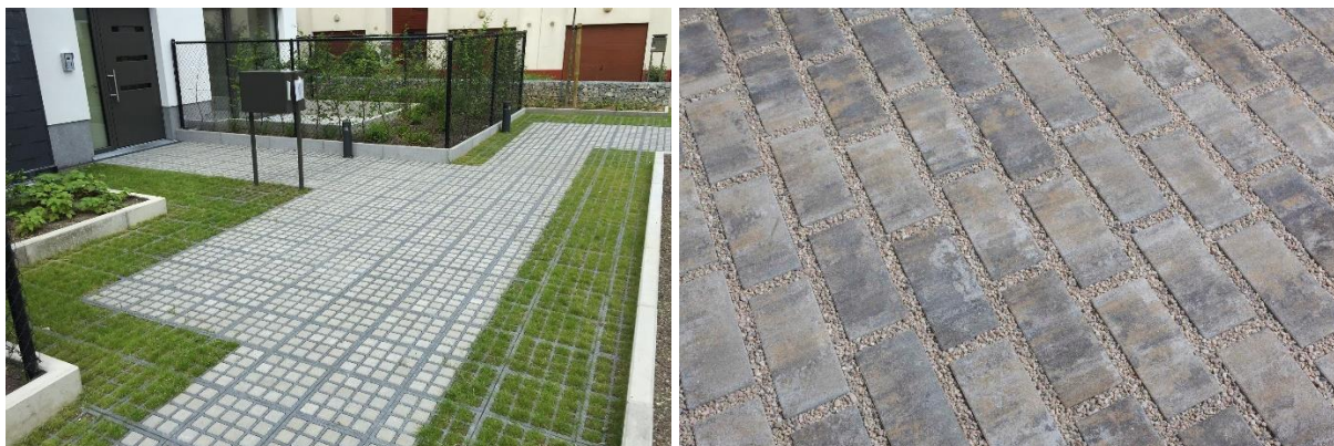
Obr. 2.7 Ukázka použití AS-TTE roštů (vlevo) a dlažby se širokou spárou (vpravo)
