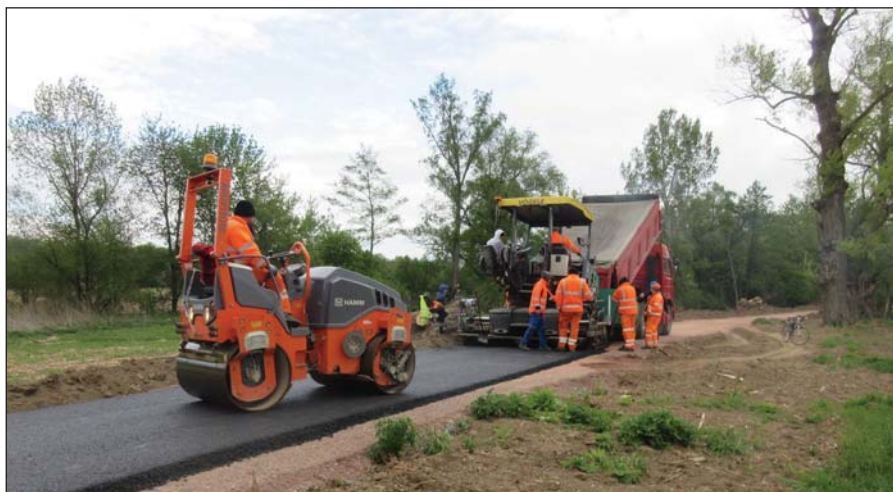
Pokládka asfaltu na budovaném úseku Ponětovice–Kobylnice
