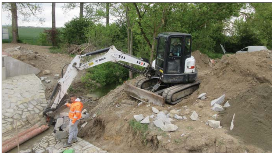
Stavba mostu přes potok v Ponětovicích
