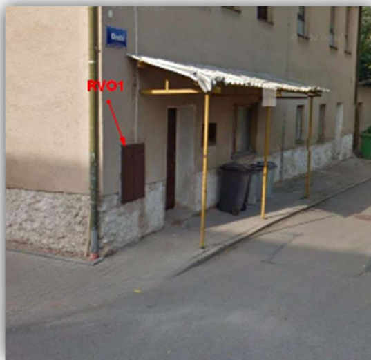
Obrázek 18 Rozvaděč veřejného osvětlení 1 (VO 3)
