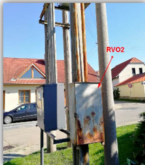
Obrázek 19 Rozvaděč veřejného osvětlení 2 (VO 1)
