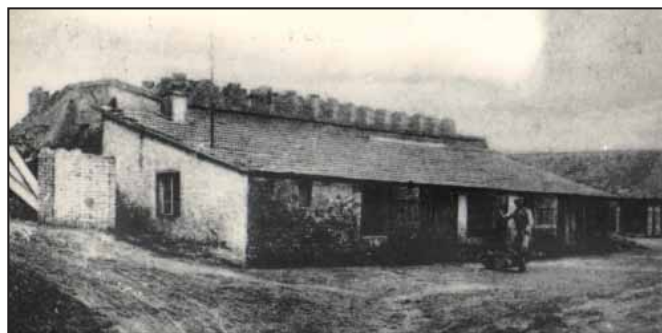
Dvě pece s řadami „výduchů“, které vyčnívají za přístřeškem na ukládání cihel.
