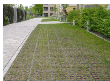
Příklady povrchů pro parkování a vjezdů na pozemky ve veřejném prostoru
