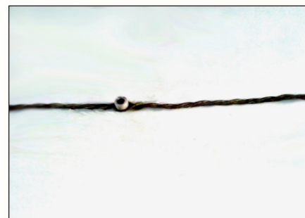
Tak se vedla elektrika „bezpečně“ po zdech a po stropě třeba ke stahovačce
